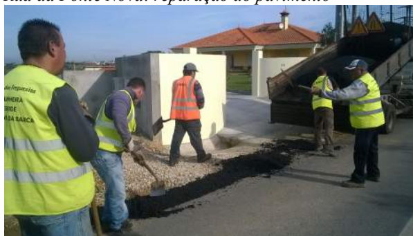
Rua da Fonte Nova: reparação do pavimento
